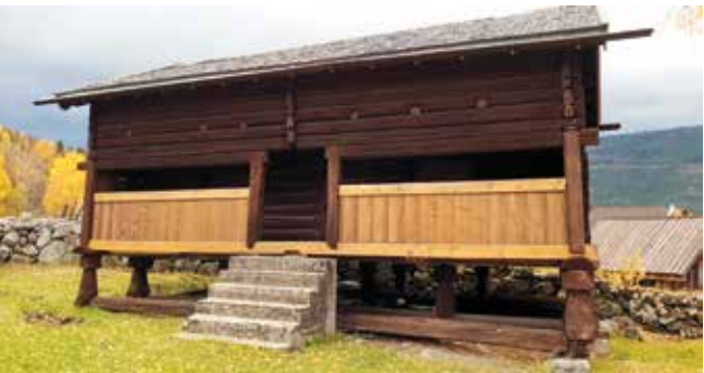
Etter omfattende oppussing i regi av Ivar Thoen i fjor (se julenummeret 2017), er det i år skiftet ut råtnete materialer i det gamle stolphuset. Dette er håndverksmessig utført av Frank Martinsen.
